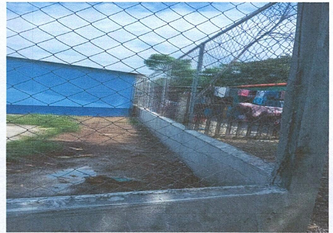
Foto 2: Mejoramiento cerco y muro perimetral.
